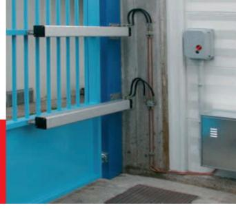
El MEC 800 es un automatismo oleodinámico eficaz para mover puertas, portones y ventanillos de superficie compacta de grandes dimensiones, hasta un peso de 800 Kg, sin ninguna limitación en el número de maniobras. Para los casos en los que se requieren prestaciones superiores, MEC 800 Special se puede instalar en la versión con dos pistones hidráulicos y una sola centralita en cada hoja.
